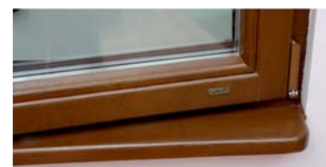
parapet z drewna dębowego
